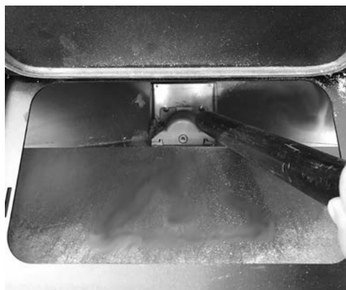
Fig. 31 - Limpeza do reservatório
