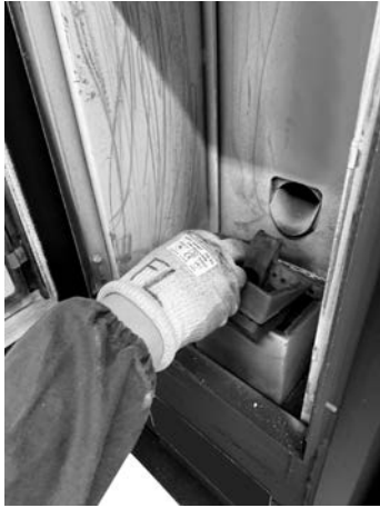
Fig. 27 - Remoção do braseiro
