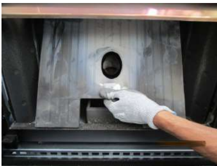
Fig. 39 - Remoção ferro fundido central
