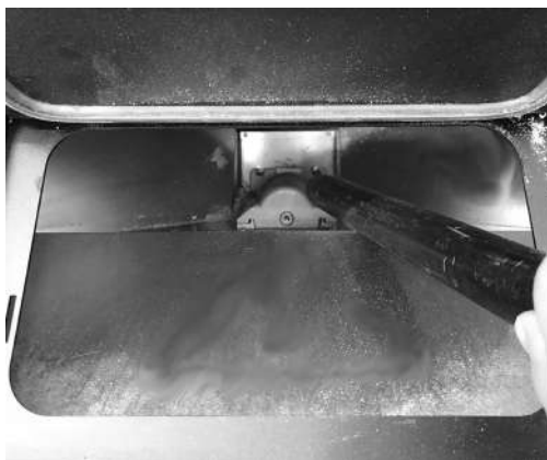
Fig. 30 - Limpeza do reservatório
