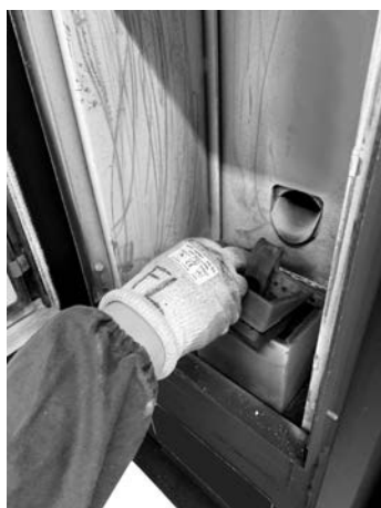
Fig. 33 - Remoção do braseiro
