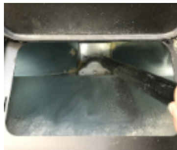
Fig. 36 - Limpeza do reservatório
