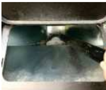
Fig. 37 - Limpeza do reservatório
