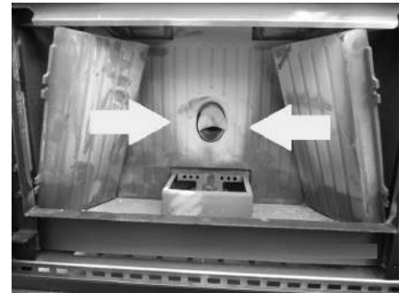
Fig. 33 - Remoção dos ferros fundidos laterais
