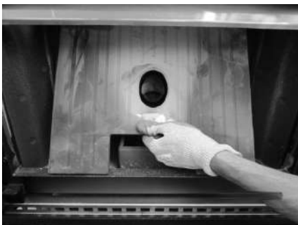
Fig. 34 - Remoção ferro fundido central
